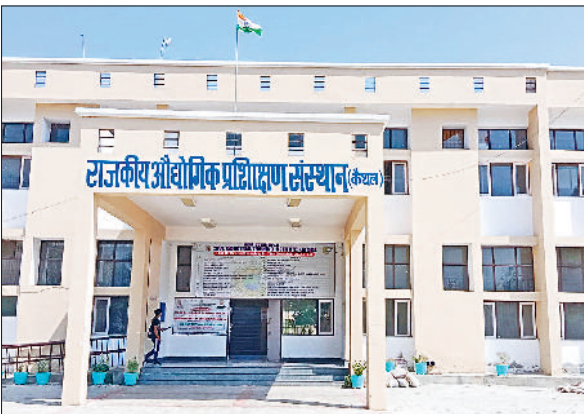
कैथल। राजकीय आईटीआई कैथल का भवन।
